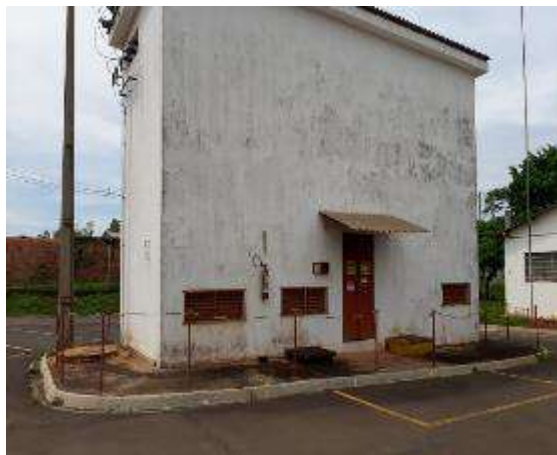
Vista casa de força
