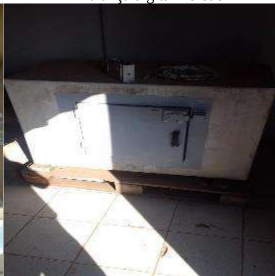
Cofre concreto com porta em aço
