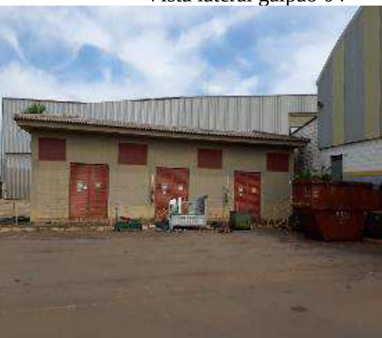
Vista casa de força
