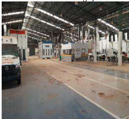
Panorama interno galpão 02
