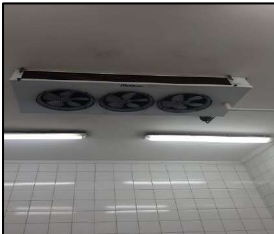
Evaporador de ar 3 forçadores
