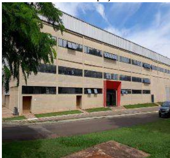
Panorama externo prédio 10
