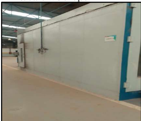
Lateral cabine de pintura
