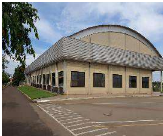
Panorama externo galpão refeitório
