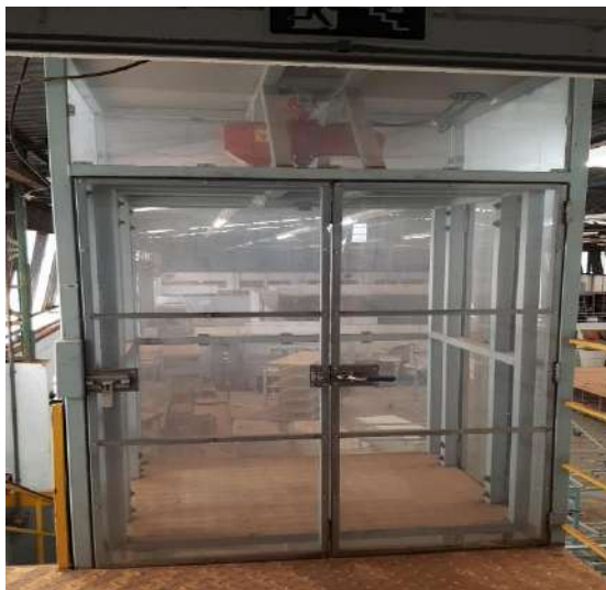
Elevador de carga
