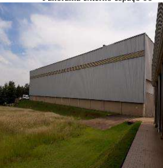
Panorama externo prédio 10
