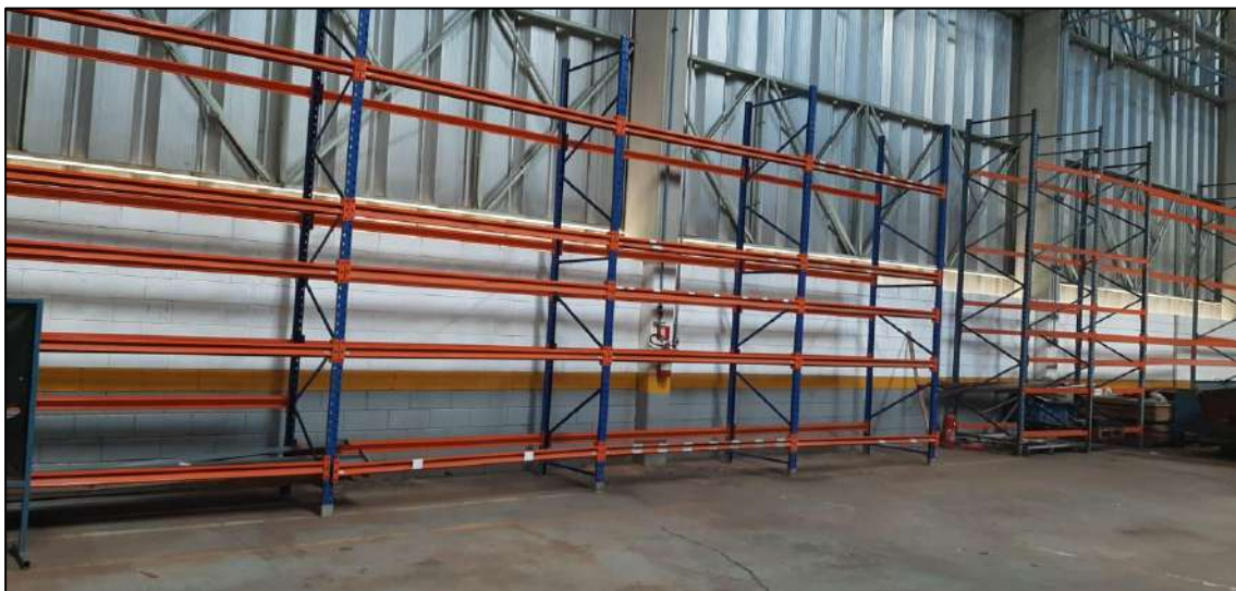
Estante metálica porta palete – Nº bem: 50138
