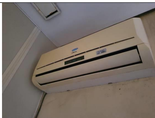
Item 10: Evaporadora de ar condicionado, marca Carrier.
